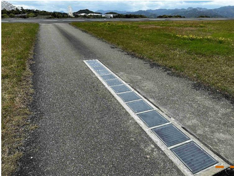
全景（49kNの輪荷重に耐えるソーラープレートを12枚敷設）
