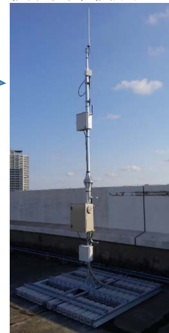
横須賀市役所屋上
