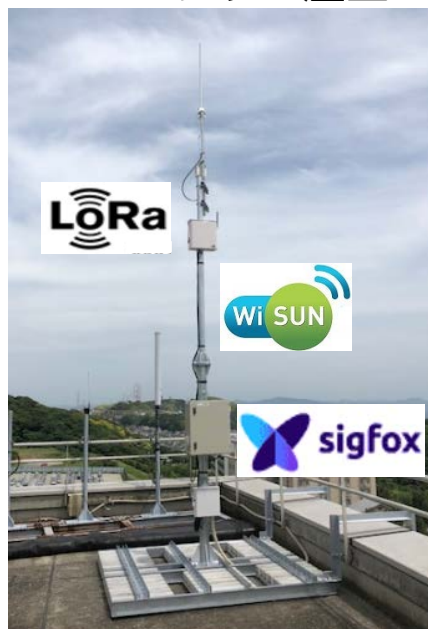
YRPセンター屋上
